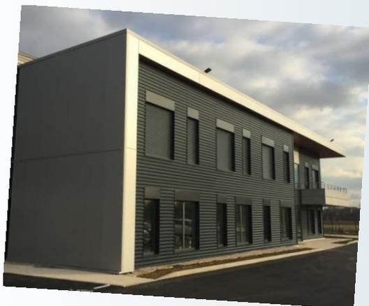
Depuis sa création, Aluroy profile la lame monoparoi en aluminium S80. Son outil industriel dernière génération lui permet de répondre aux chantiers du Tertiaire auprès des maîtres d'ouvrages sur des projets en lames pleines (S80) ou lames microperforées (S80P) laissant passer la lumière.
